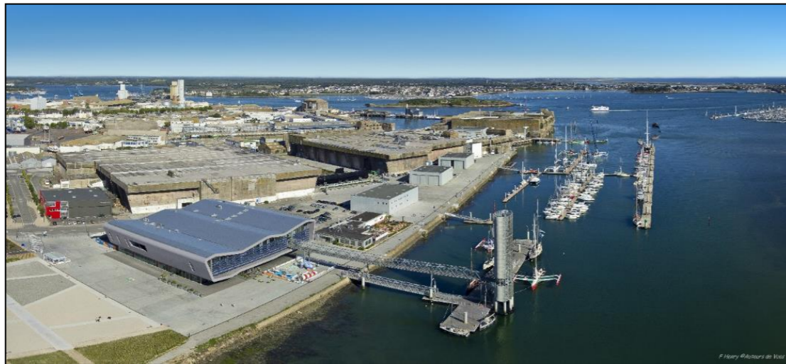
FIGURE 13 - PORT DE LORIENT LA BASE (SOURCE : PATRIMOINE.LORIENT.BZH - INGEROP)
