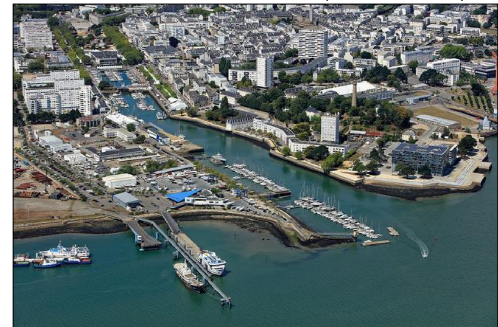
FIGURE 15 - VUE AERIENNE DU PORT DE LORIENT CENTRE DANS SA GLOBALITE (SOURCE : FIGARO NAUTISME - F. HEDELIN, 2020 - INGEROP)
