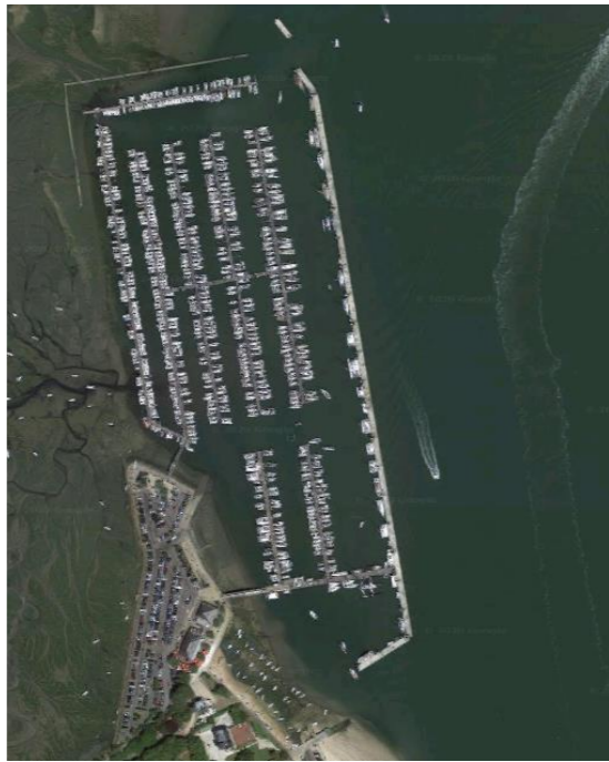
FIGURE 16 - VUE DU PORT DU KERNEVEL (SOURCE: GEOPORTAIL)
