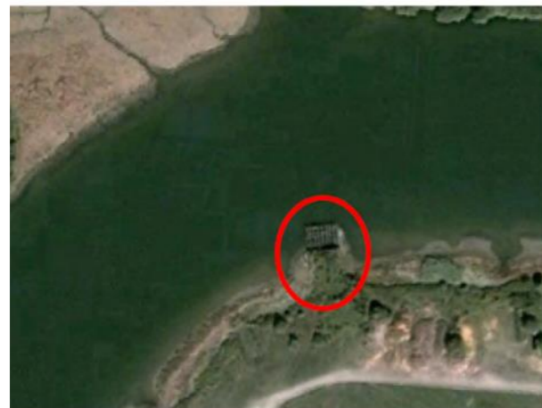
Quai et estacade en bois, vue satellite (2005)
